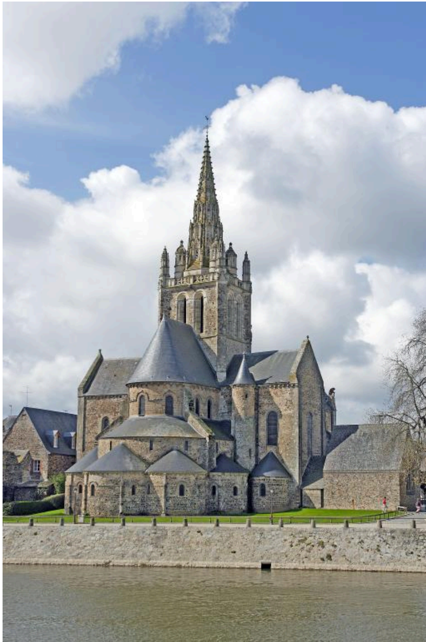
Chevet. Vue d'ensemble depuis le nord-est.
