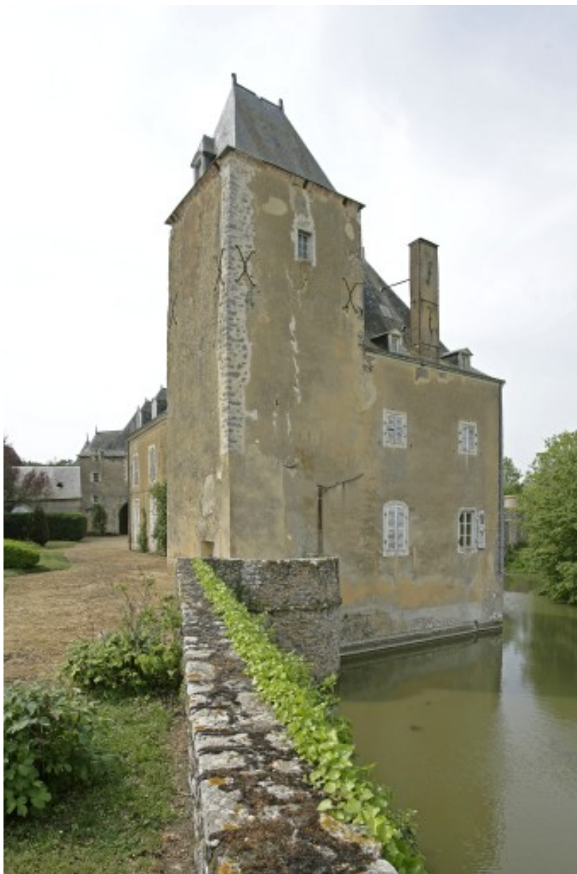
Le logis vu depuis l'est.
