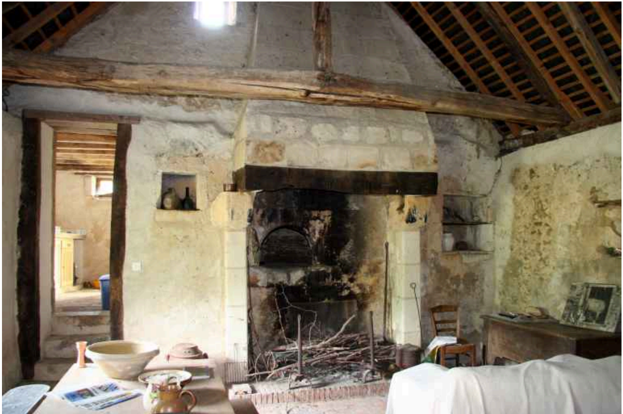
Habitation du meunier : salle sous charpente.
