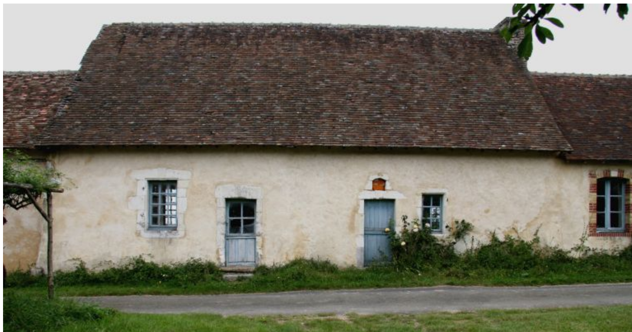
Maison n° 1 : façade sur le chemin.
