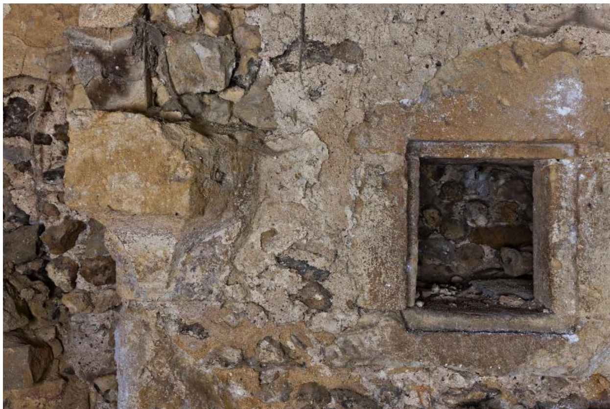
Détail de la cheminée et du placard mural, XVI e siècle.
