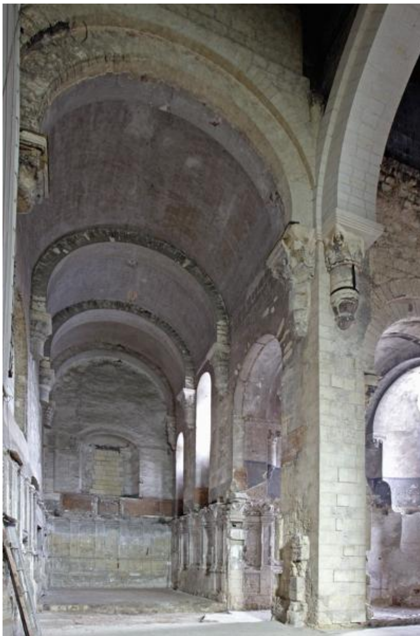
Eglise : transept, vue d'ensemble en axe sud-nord.
