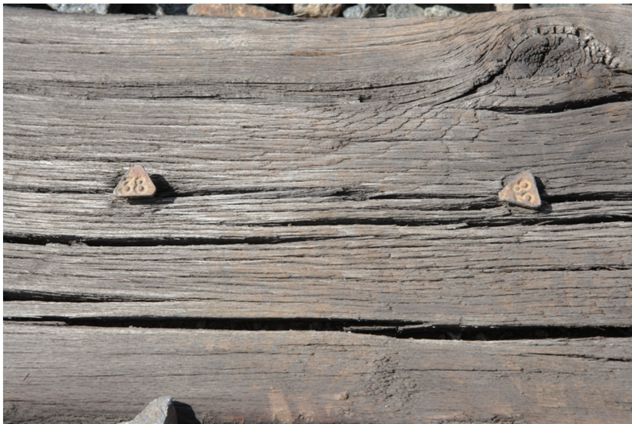
Clous de datation des traverses : 1938.
