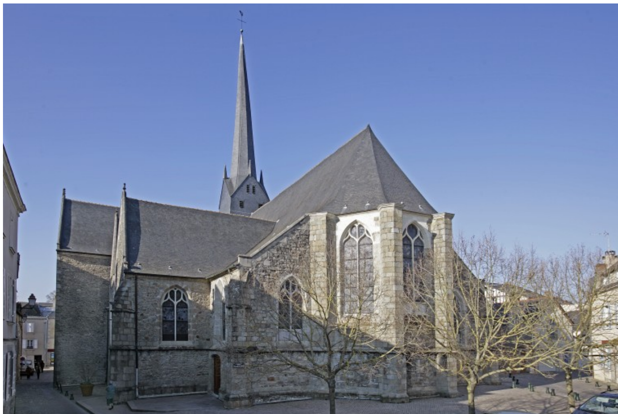
Chevet restauré : vue d'ensemble depuis le sud.
