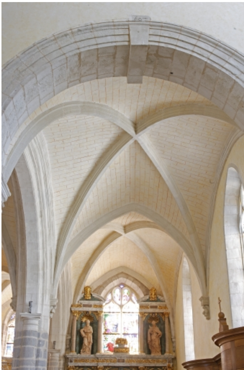
Deuxième collatéral droit du chœur, voûte restaurée : vue d'ensemble vers le sud.
