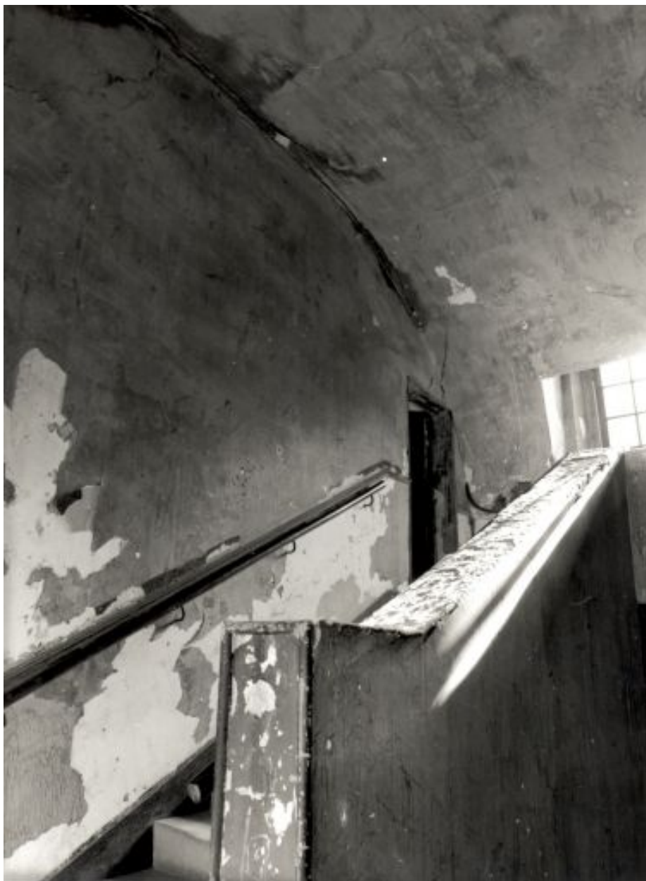
Cage d'escalier : le couvrement.
