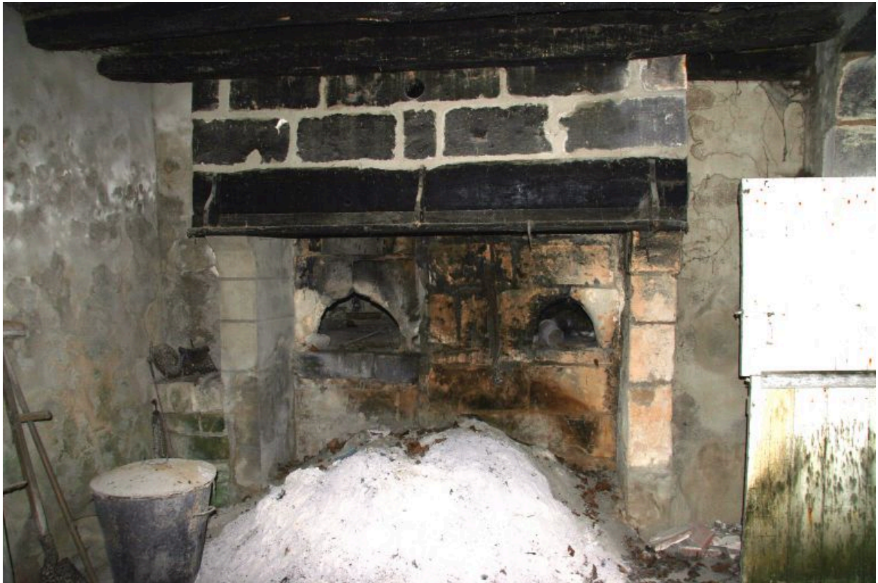
La buanderie : la cheminée avec deux fours.
