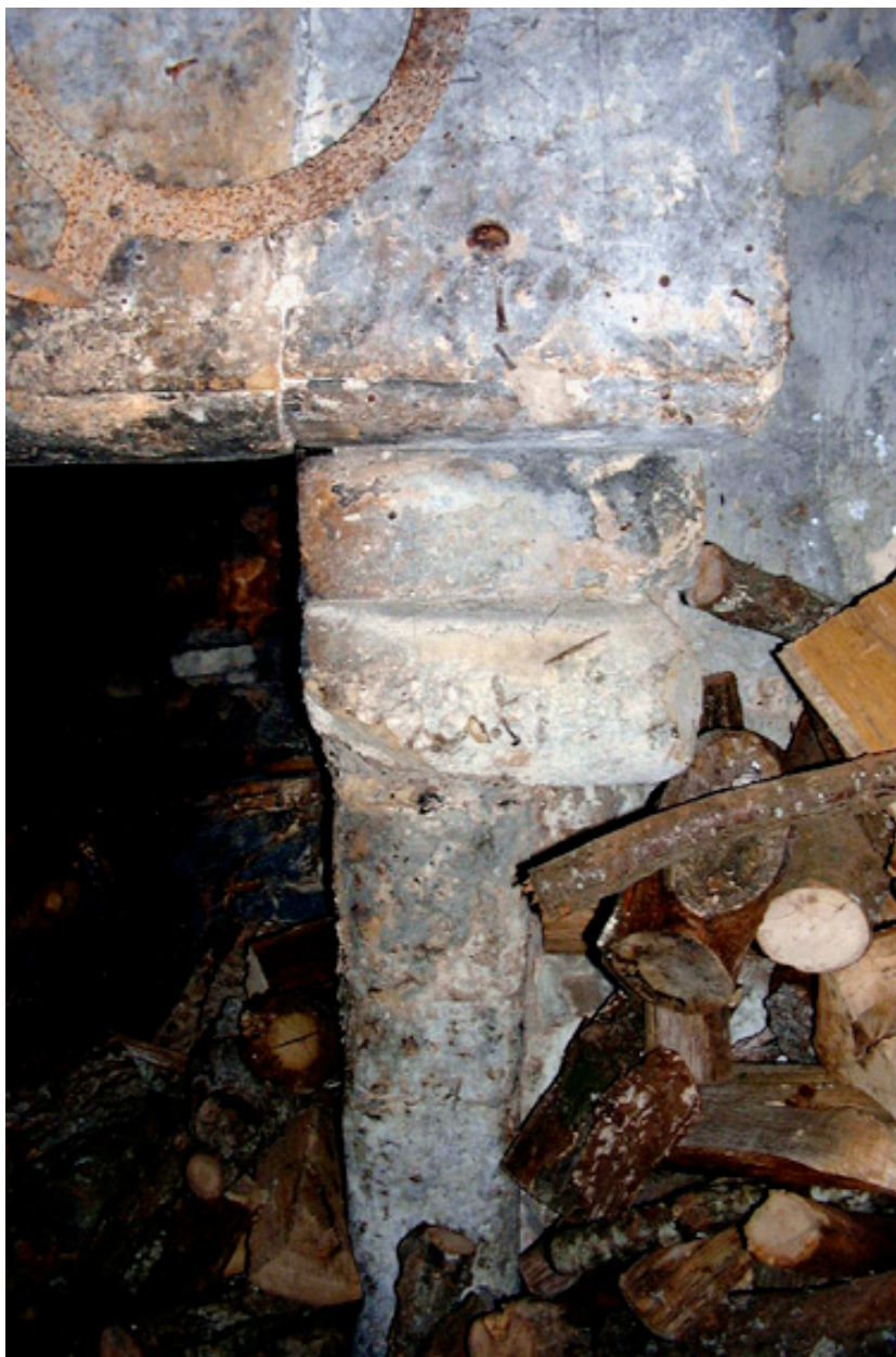
Détail du piédroit de droite de la cheminée du rez-de-chaussée.
