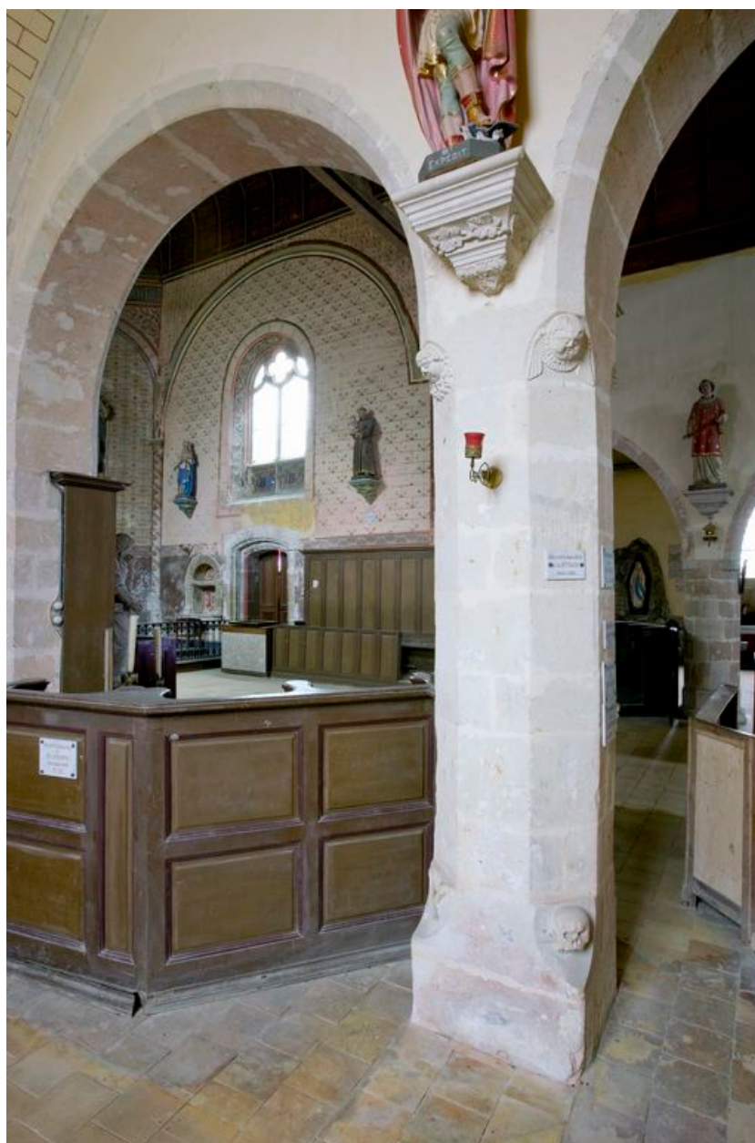
Détail du pilier des arades de la chapelle gauche.
