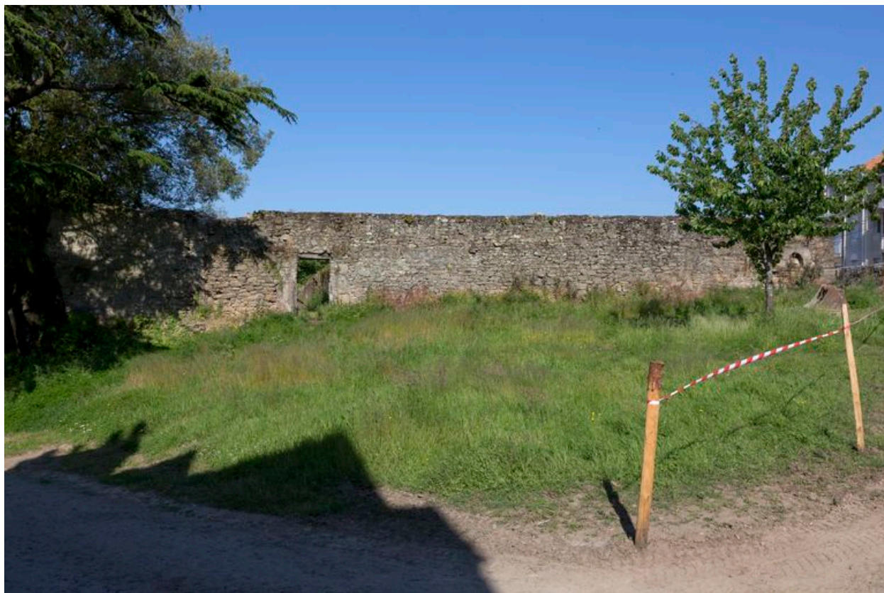
Ancien mur de clôture.
