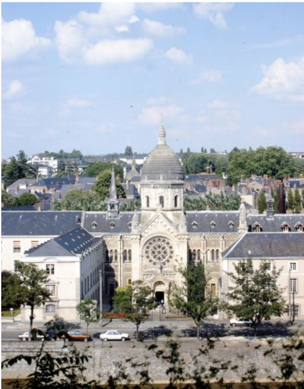
Façade ouest : vue d'ensemble.
