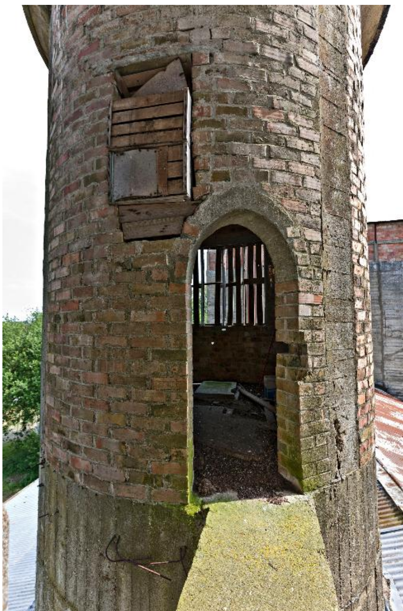
Tour accessible du premier niveau du four 1.
