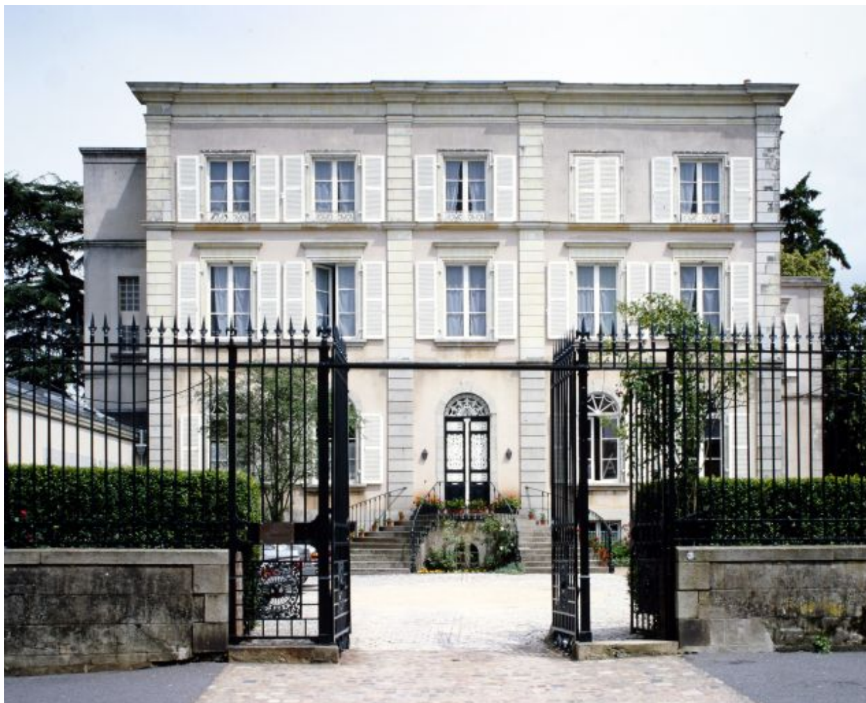
Elévation antérieure sur cour.
