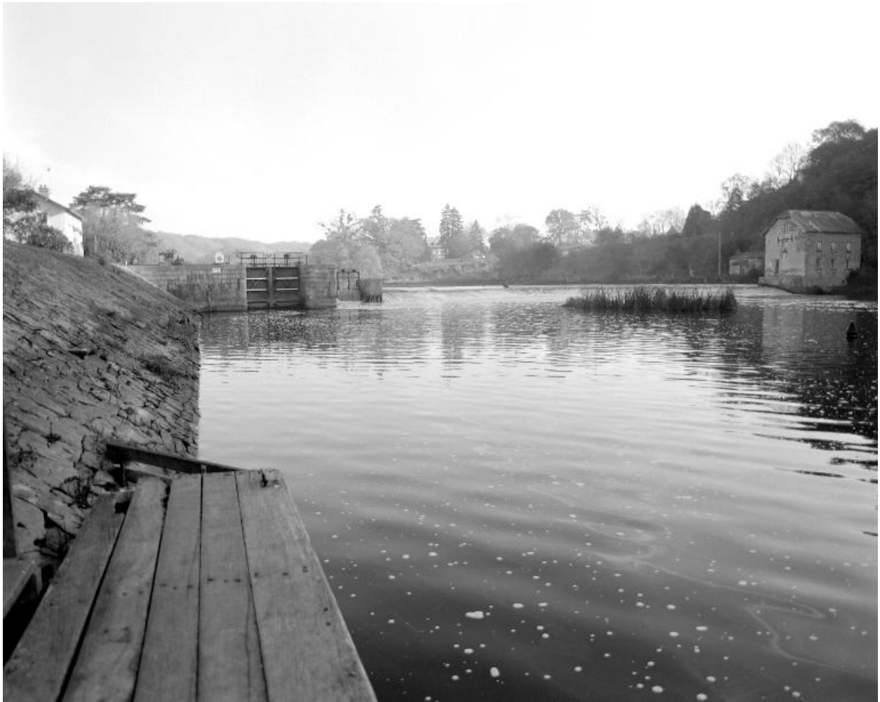
Vue d'ensemble depuis le ponton situé rive droite, en aval : maison éclusière, écluse, pertuis, barrage, moulin.
