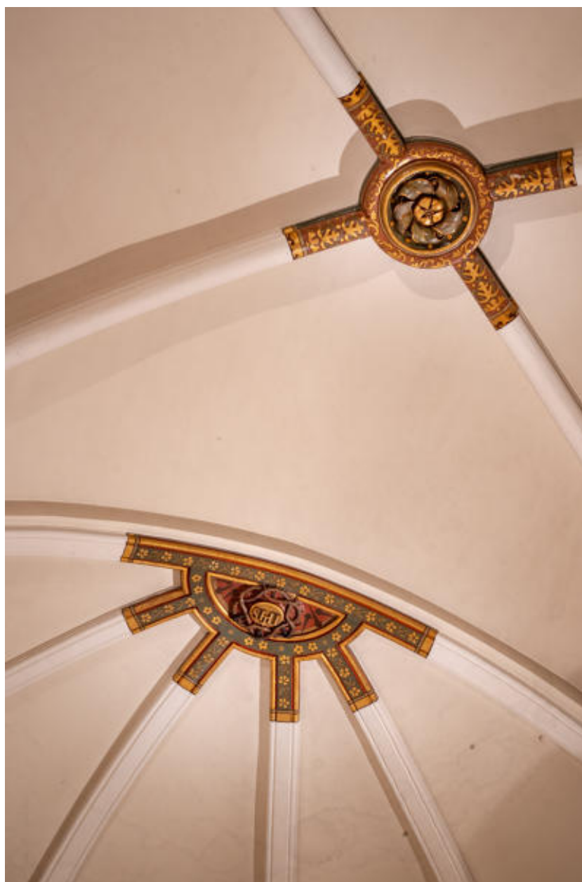
Un détail des clés de voûte du chœur.
