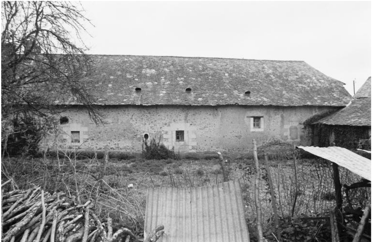
Bâtiment de dépendance : façade nord.
