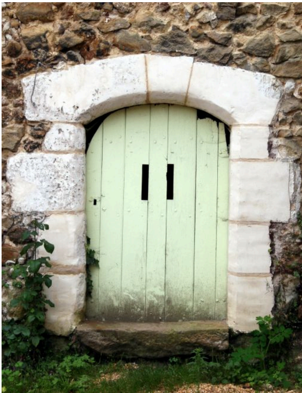
Façade sur cour : porte de la cave.
