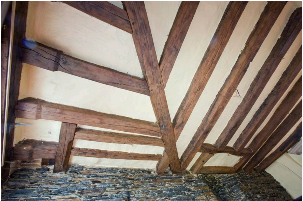
1er étage, pièce principale, partie antérieure gauche : détail du plancher du 2e étage avec ses reprises.
