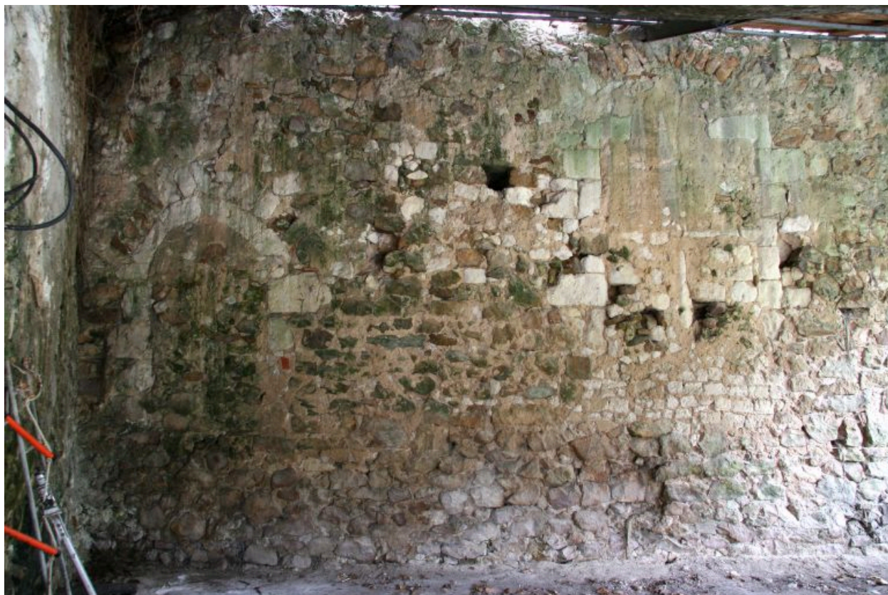
Pignon de la salle médiévale : porte et croisée bouchées.
