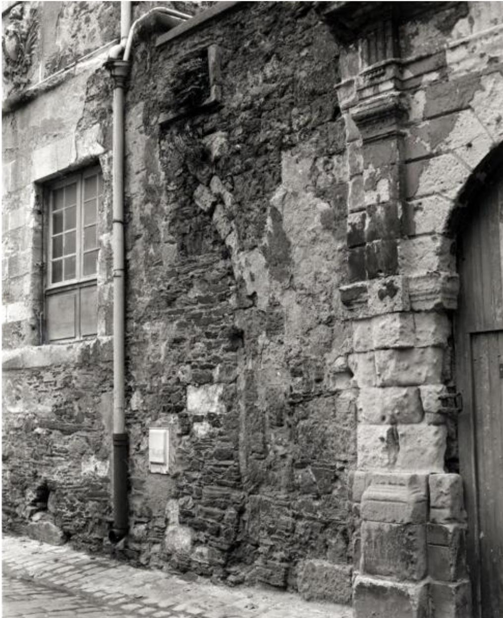
Mur de clôture de la cour ouest de l'abbatiale, élévation sur la rue de la Censerie : vestige d'une porte et d'une fenêtre murées au contact de l'aile ouest du cloître.
