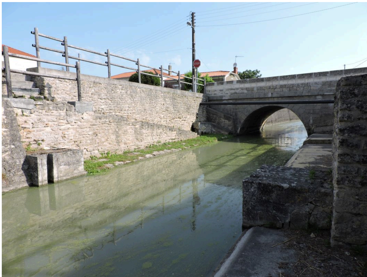
Le pont et ses abords, en aval, vus depuis le sud.
