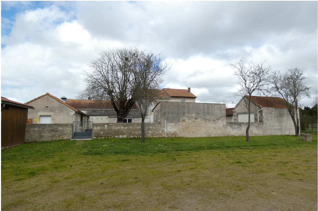
L'ancienne école vue depuis le sud.
