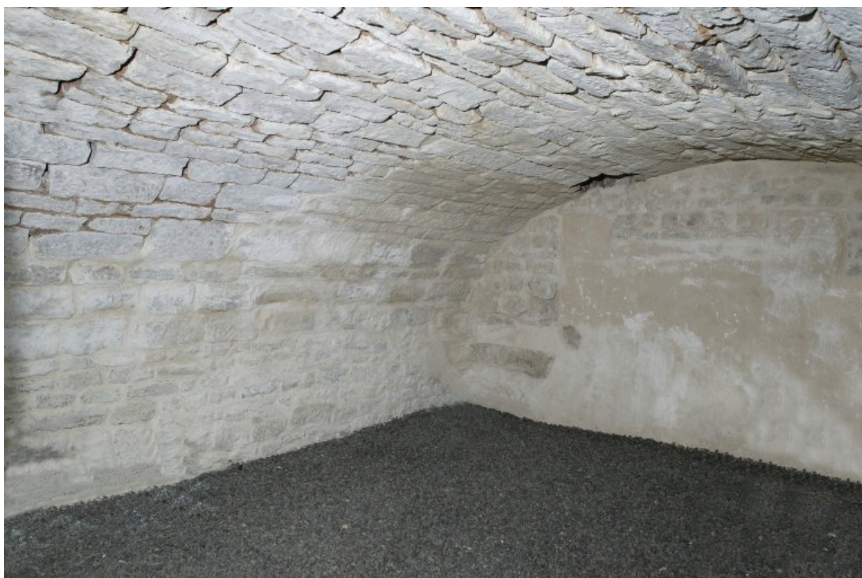
Vue du sous-sol.
