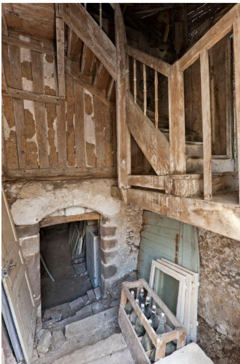
Côté rue : cave en sous-sol et escalier menant au comble.
