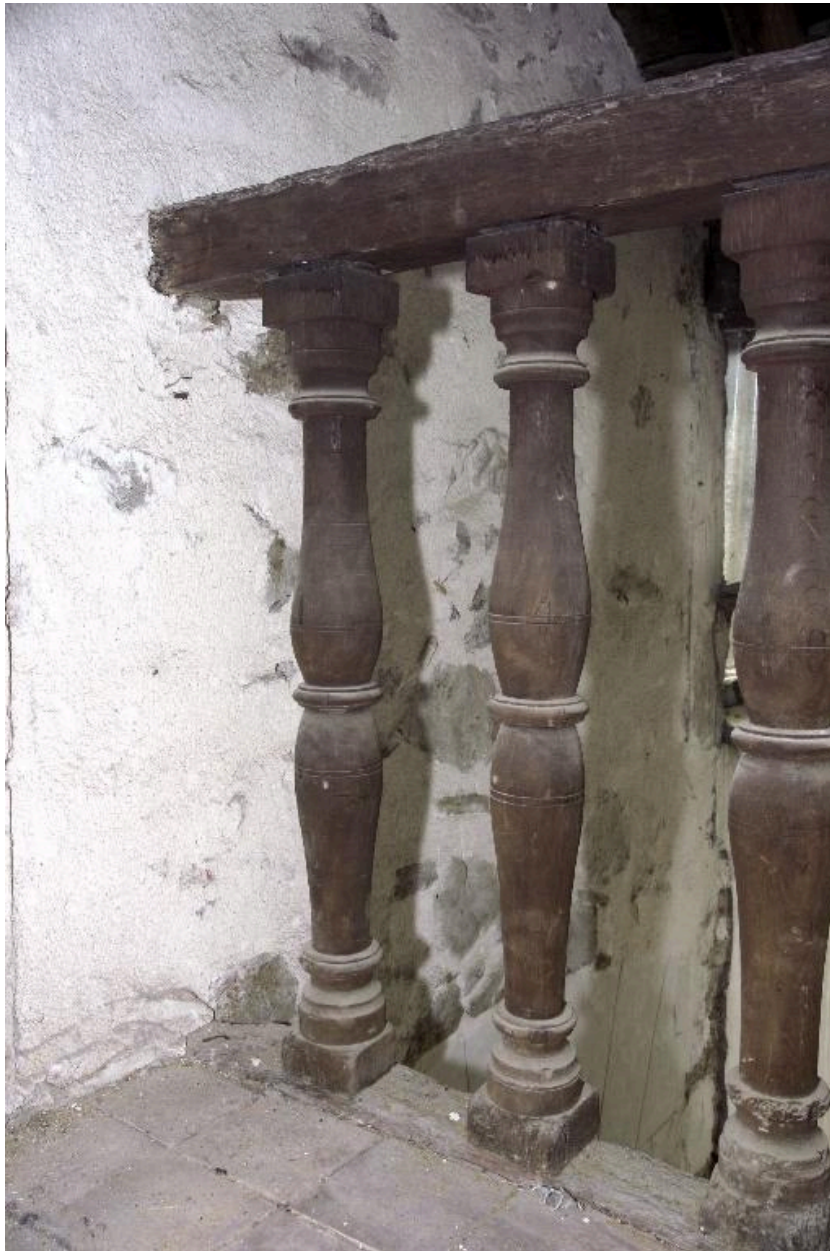
L'escalier, détail des balustres du dernier niveau.
