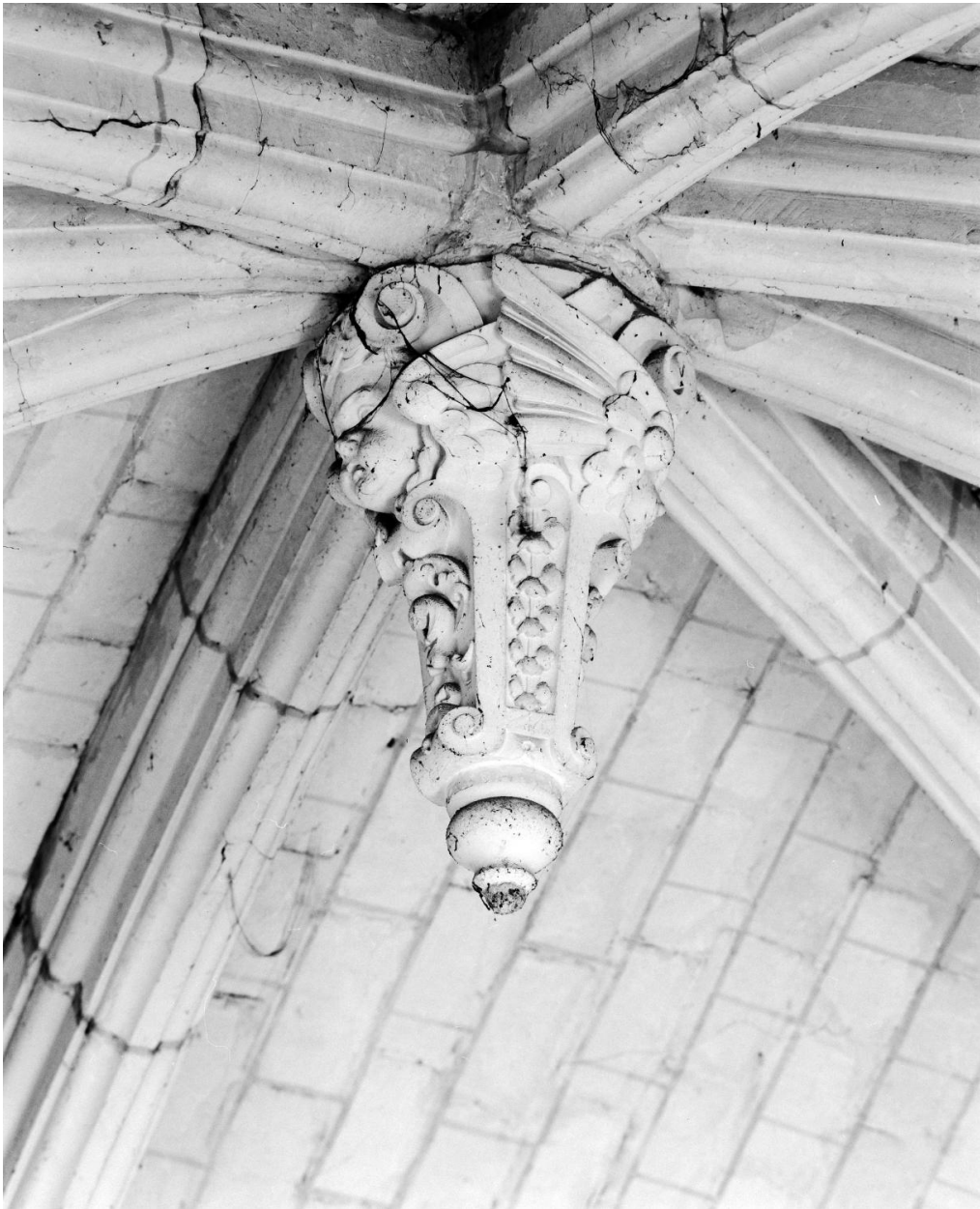
Eglise, nef, deuxième travée : clé de voûte.
