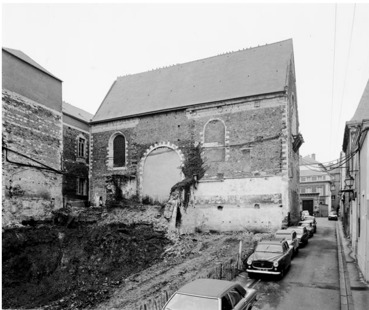
Eglise conventuelle, élévation nord avant restauration.
