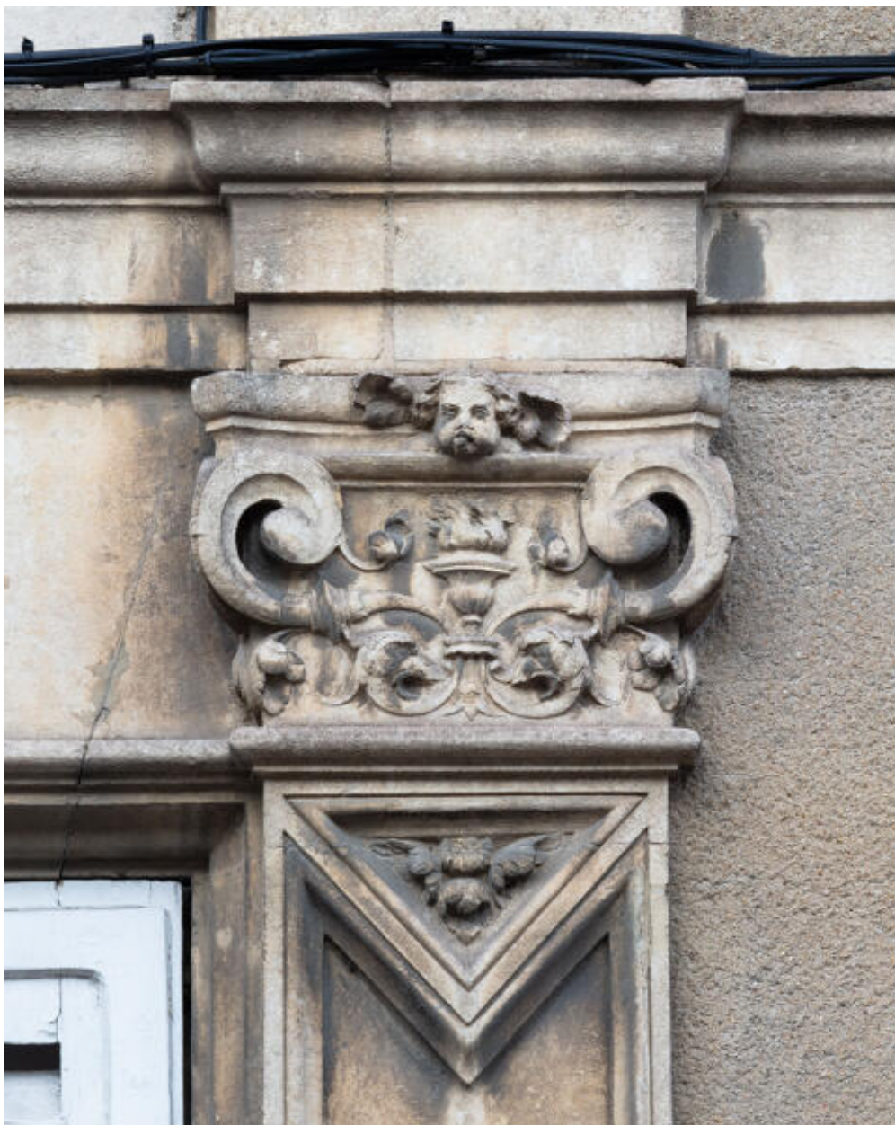
Détail du décor sculpté sur les pilastres en façade principale.
