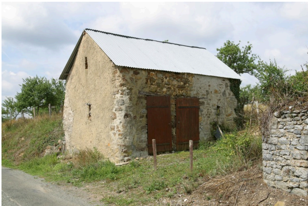
L'étable située en face des logis accolés, vue depuis le nord-est.
