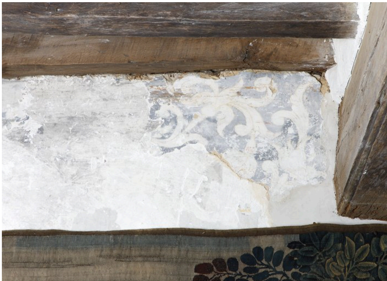
Rez-de-chaussée, salle, mur postérieur : frise de rinceau du premier décor.
