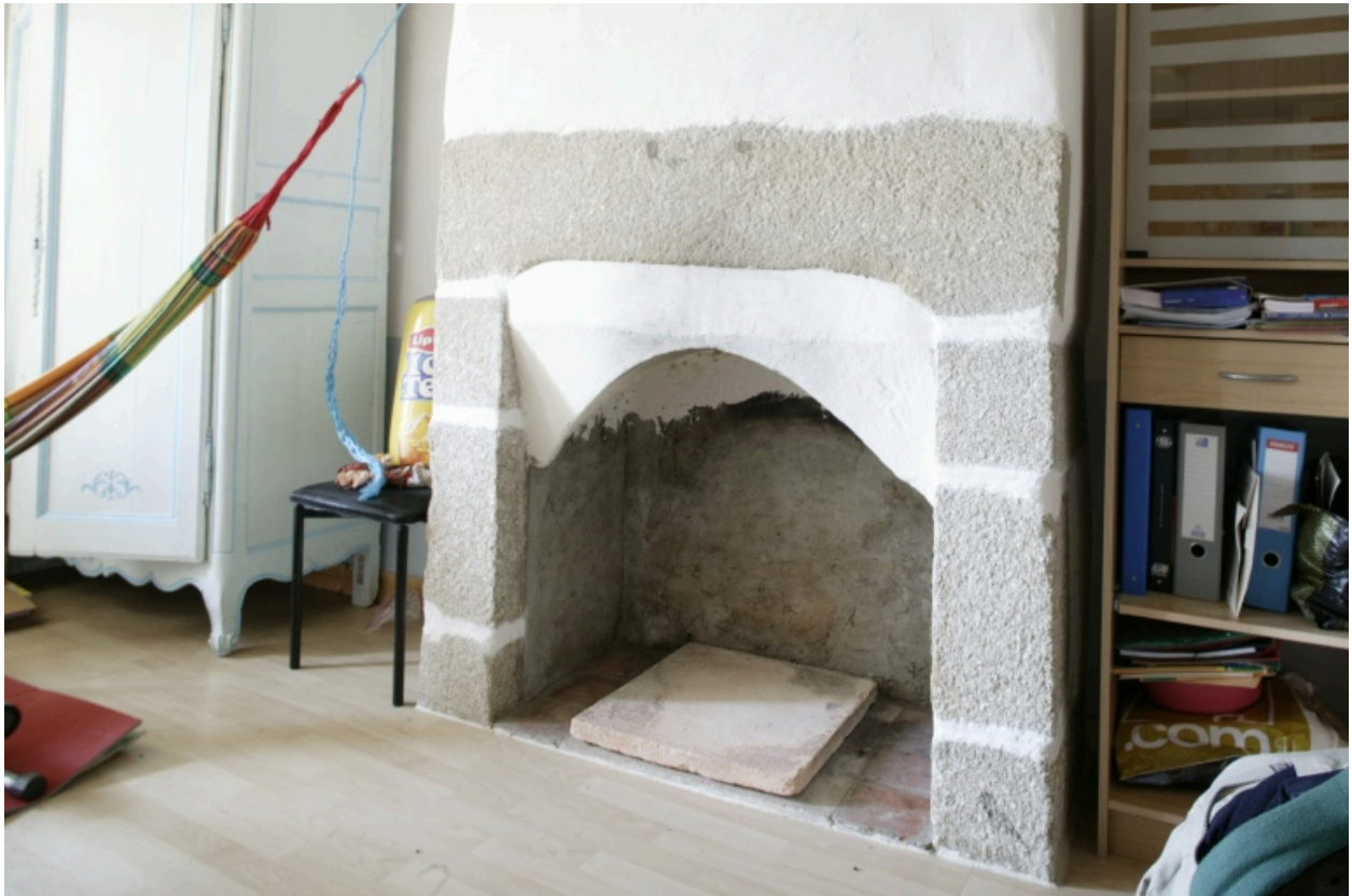
Cheminée au premier étage de la partie sur jardin.
