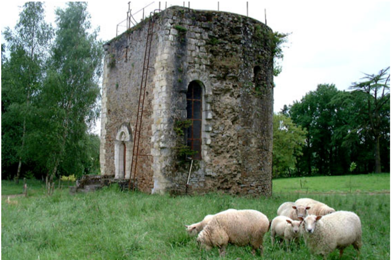
Angle nord de la tour avec arrachements de maçonneries.
