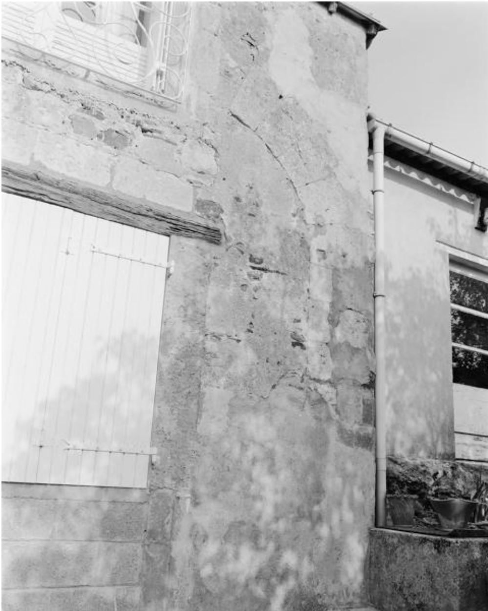
Façade postérieure de l'aile en retour d'équerre nord, détail d'un passage muré.
