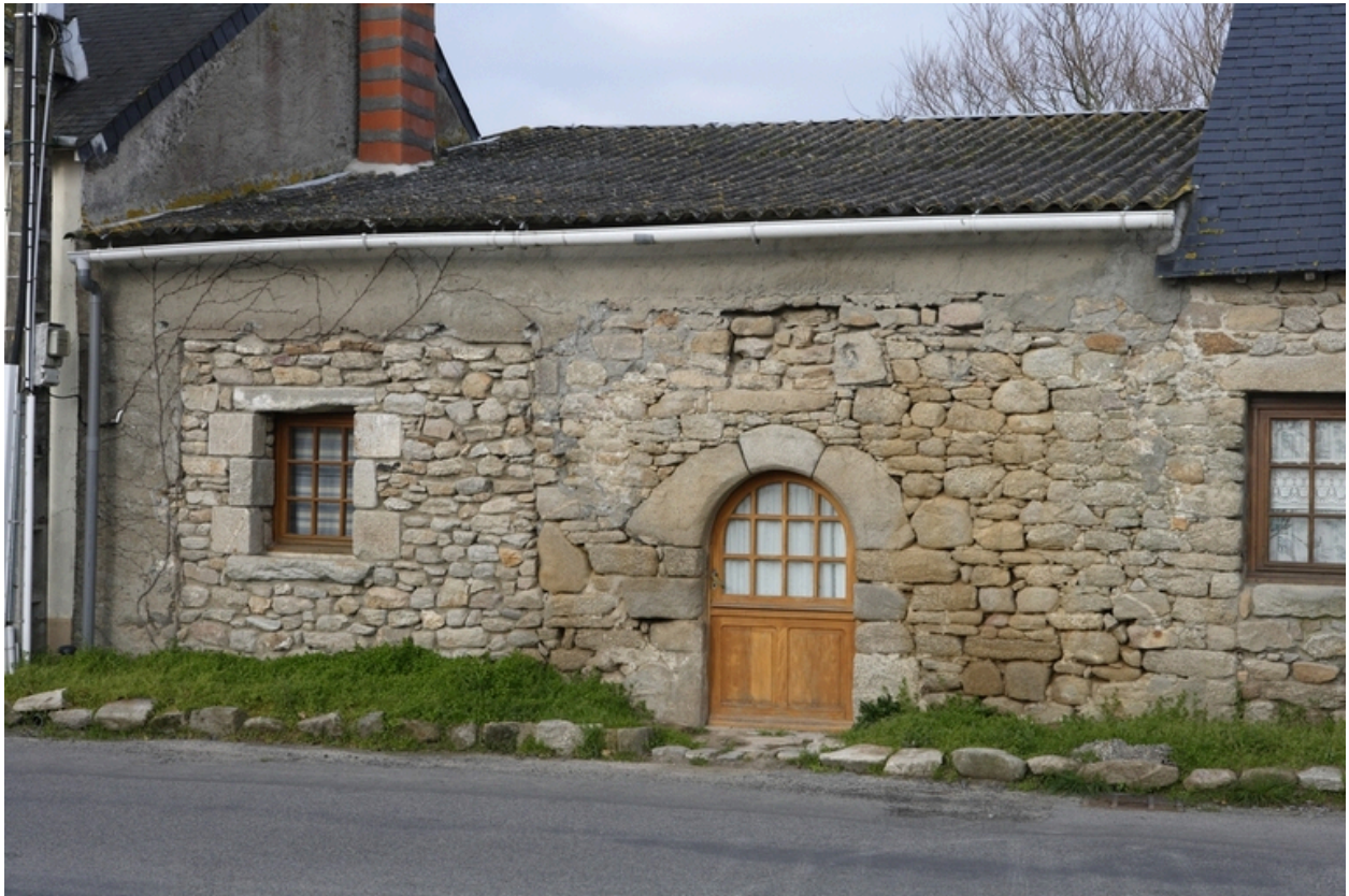
Vue du deuxième logis (20 rue de Kérignon).
