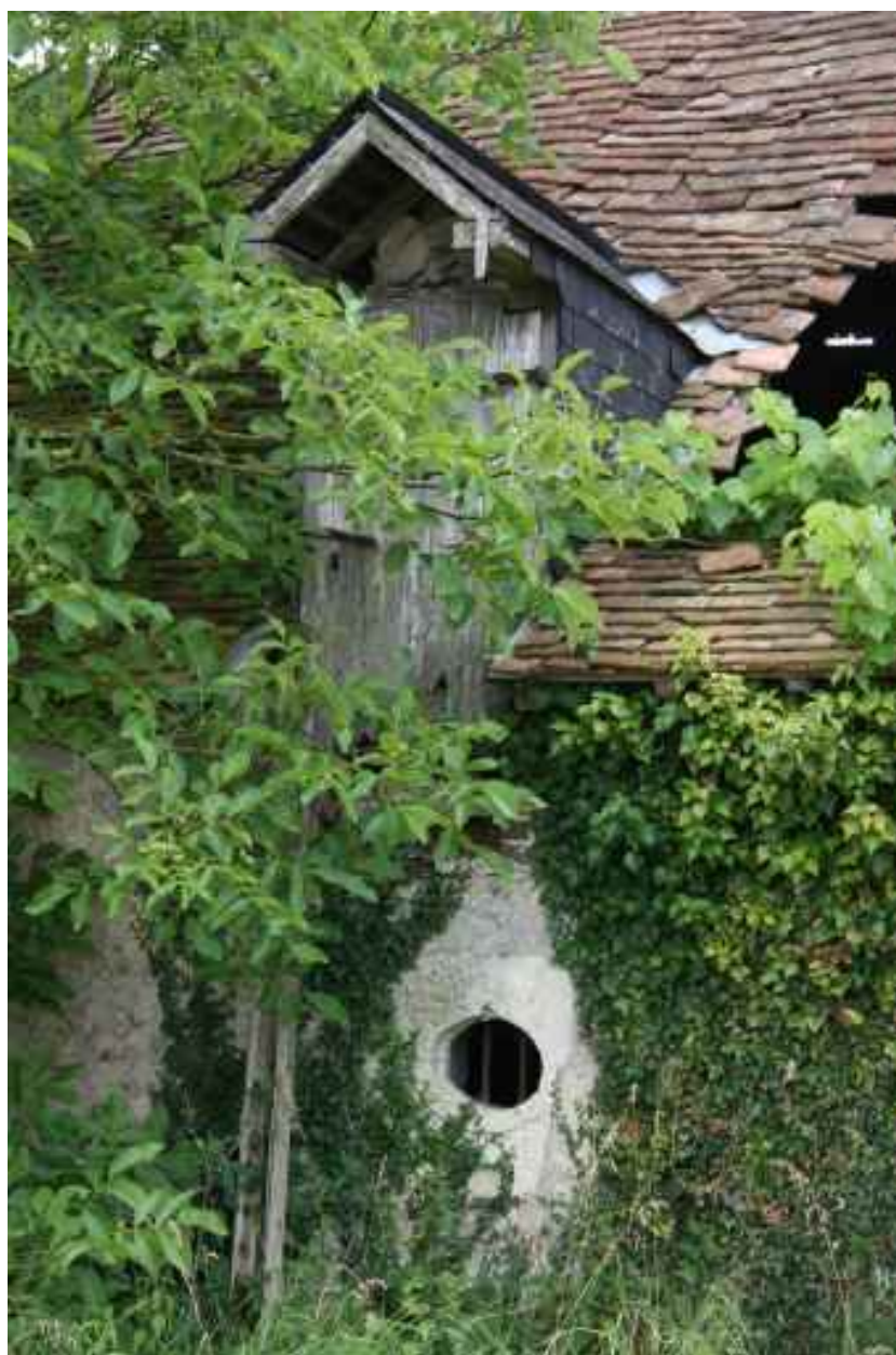
Maison 2, façade postérieure : occulus et lucarne.
