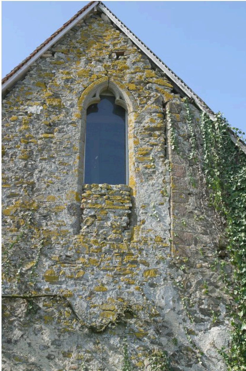
La chapelle. Détail de l'élévation est.
