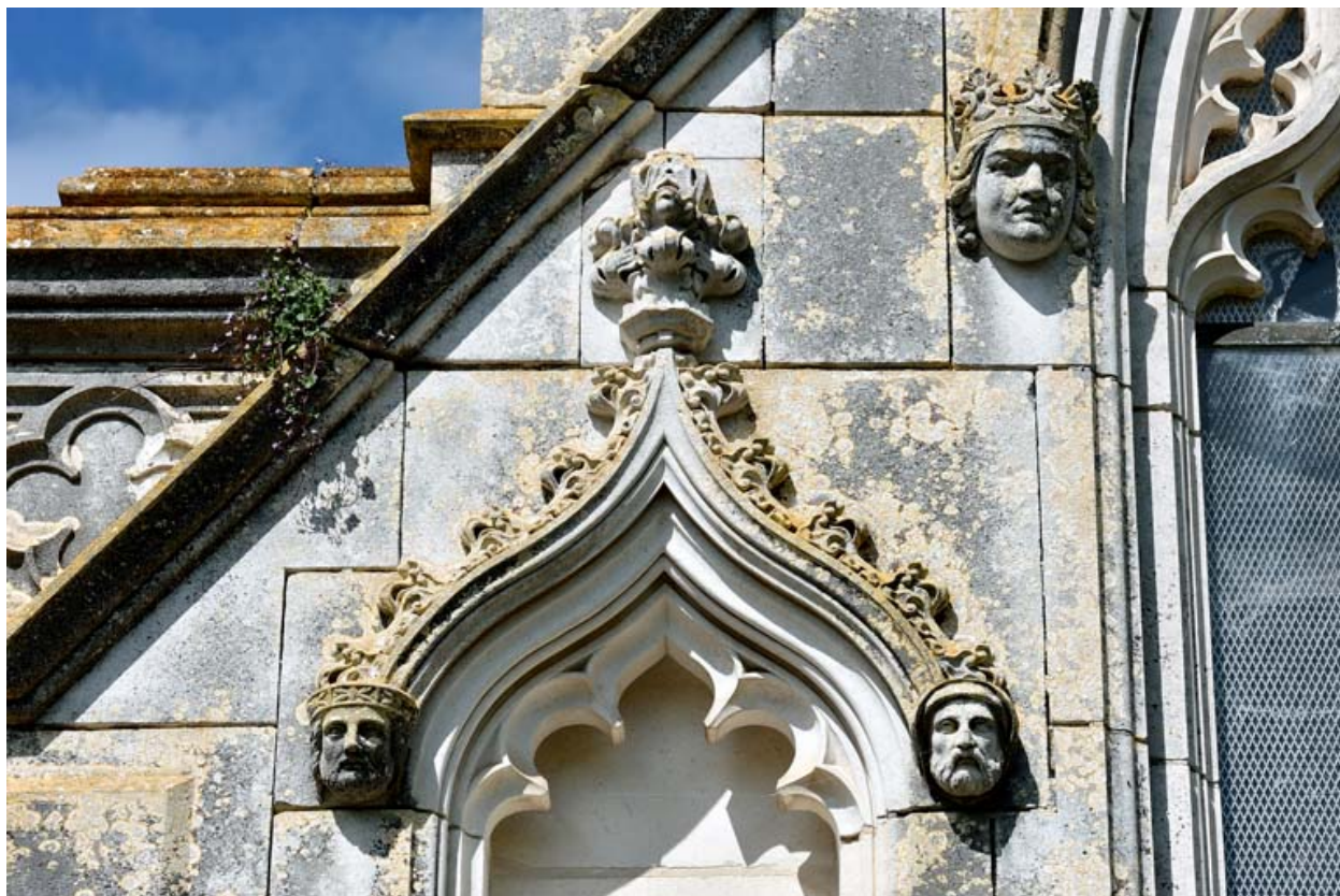
Chapelle. Pignon sud. Détail du gâble surmontant la niche gauche.
