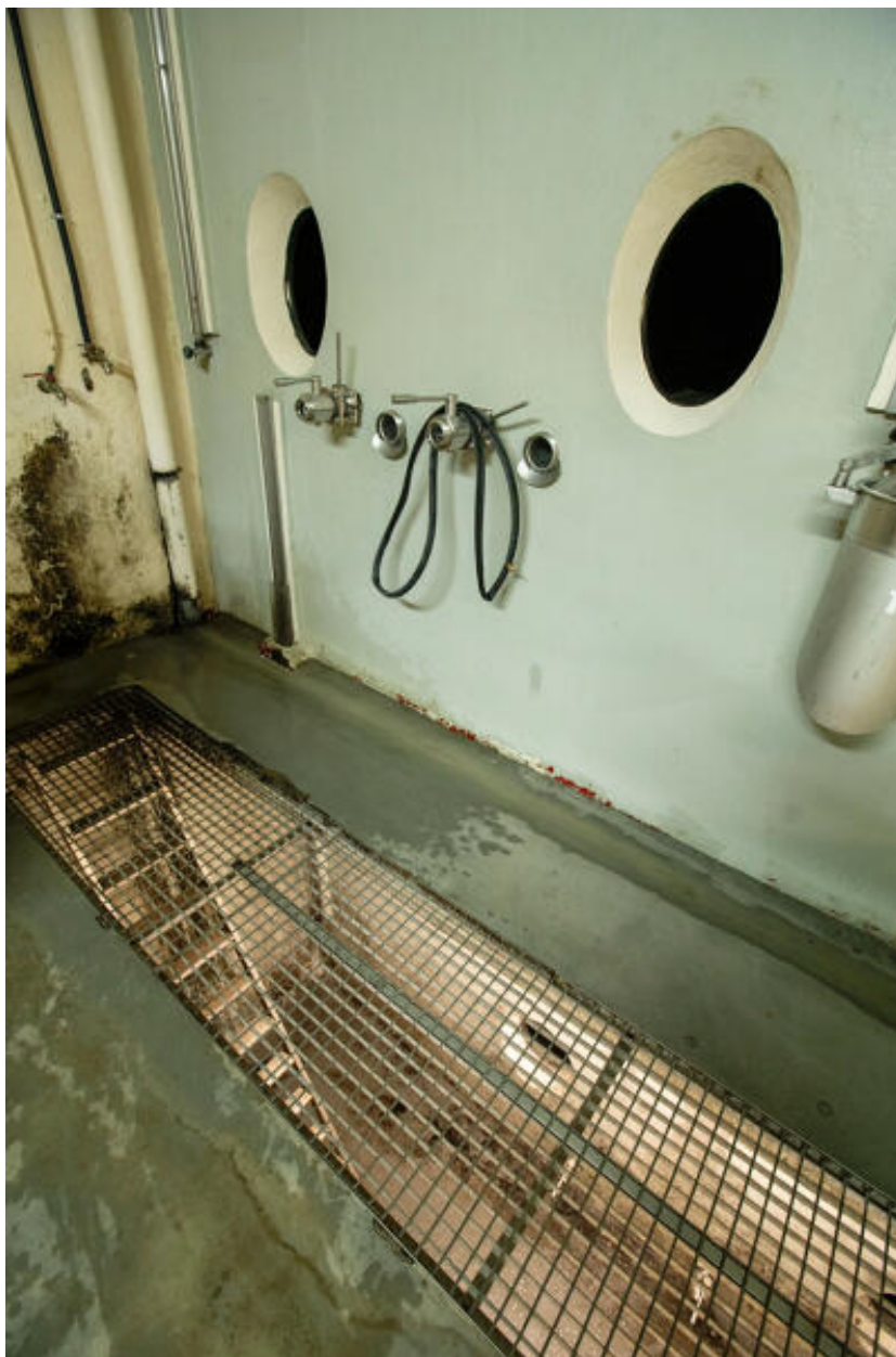
Cuverie au premier niveau et couloir de service vers le niveau inférieur.
