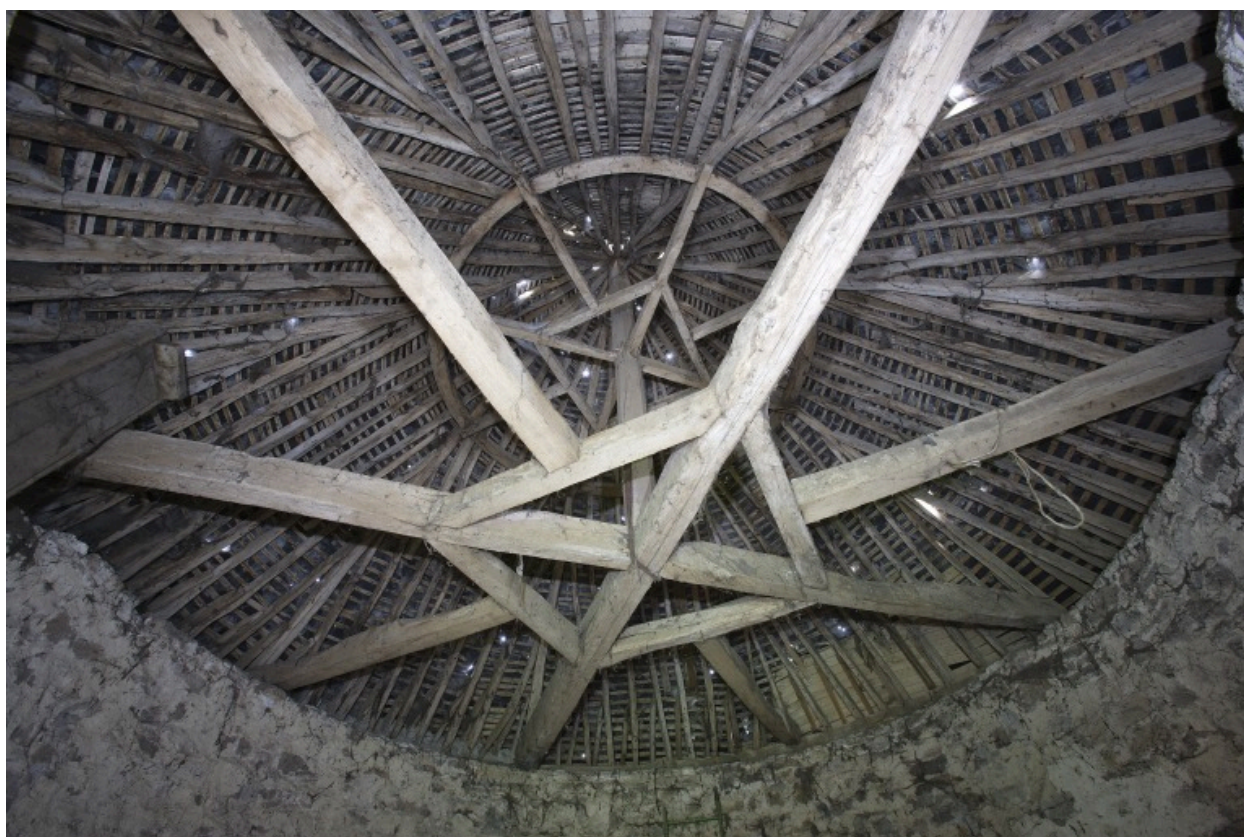
Le colombier : la charpente
