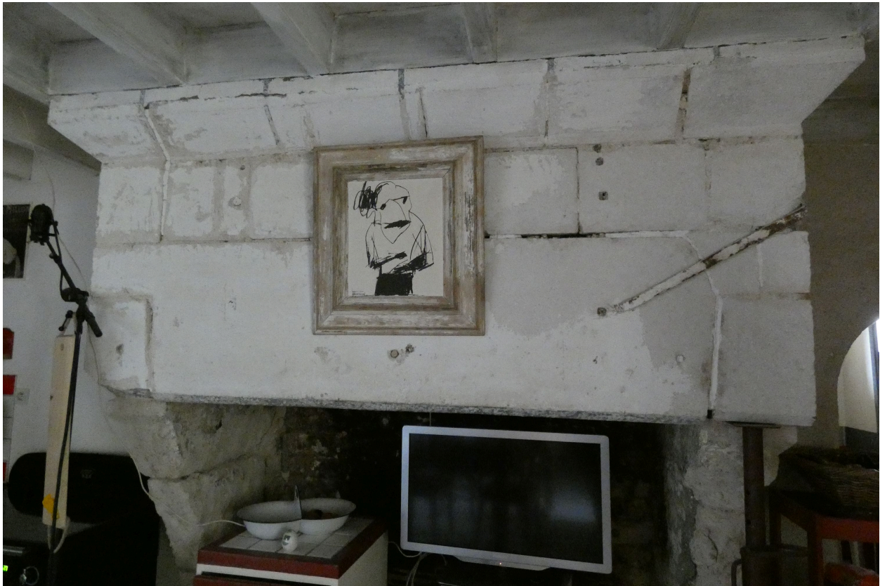
Cheminée à jambages en encorbellement, à l'intérieur du logis.
