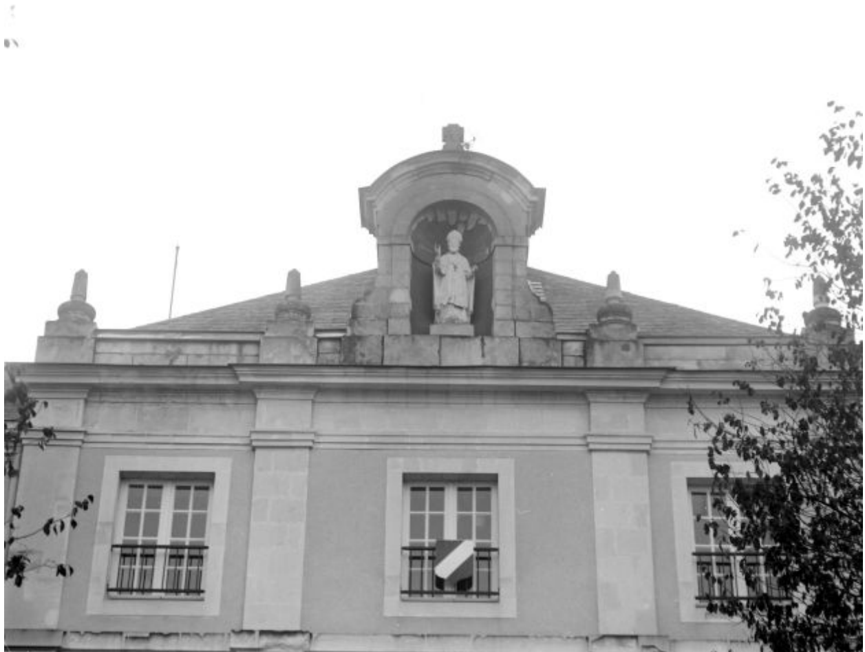
Hôpital Saint Julien : bâtiment principal détail de la niche abritant la statue de Saint Julien.
