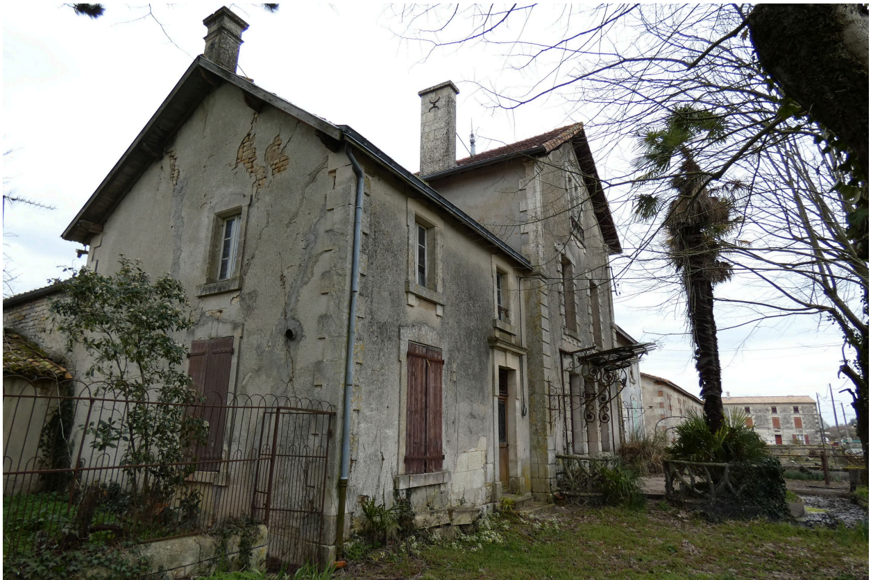
Le logis vu depuis l'ouest.
