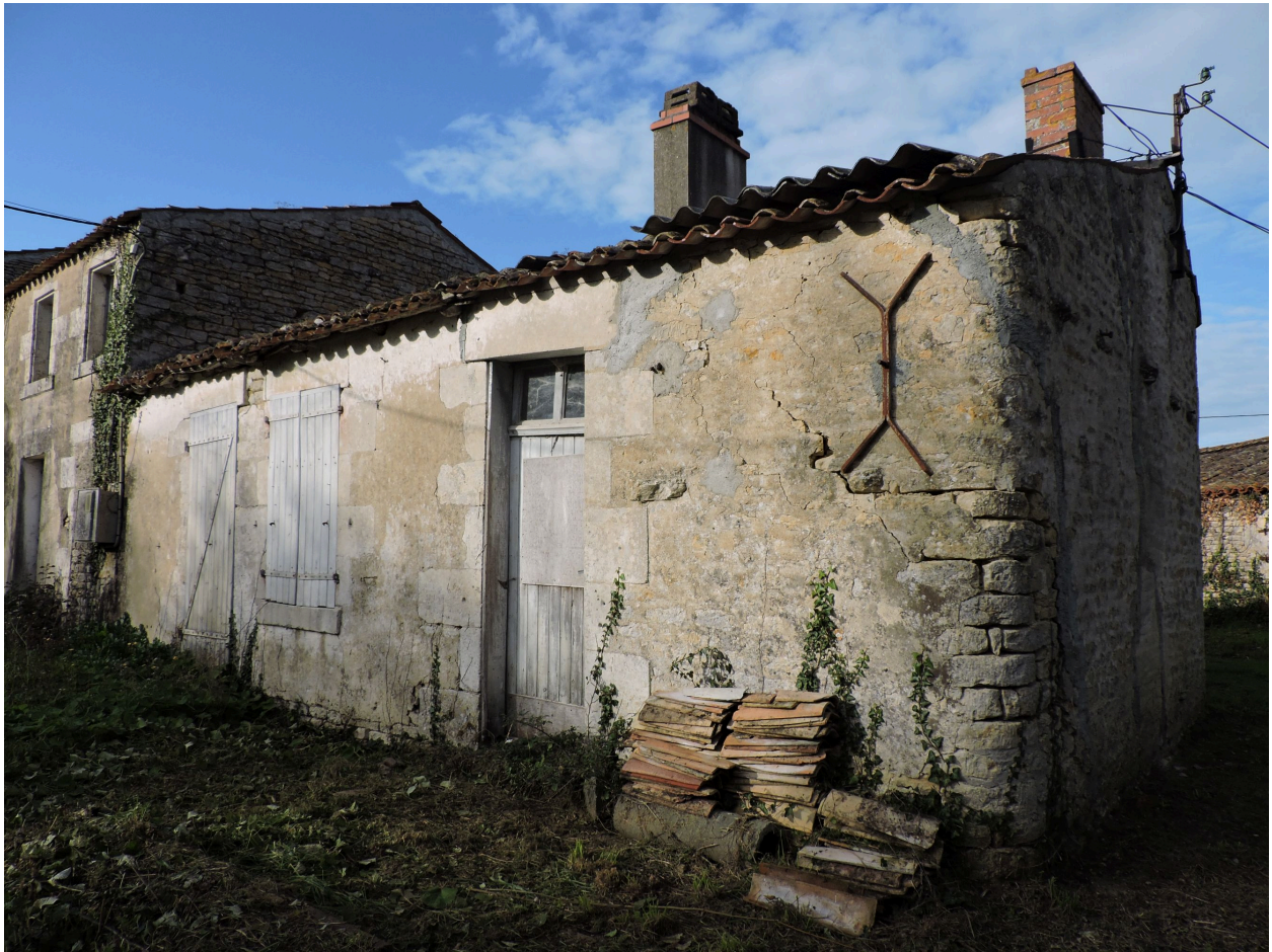
La partie du logis en rez-de-chaussée, à l'est de l'ensemble, vue depuis le sud-est.
