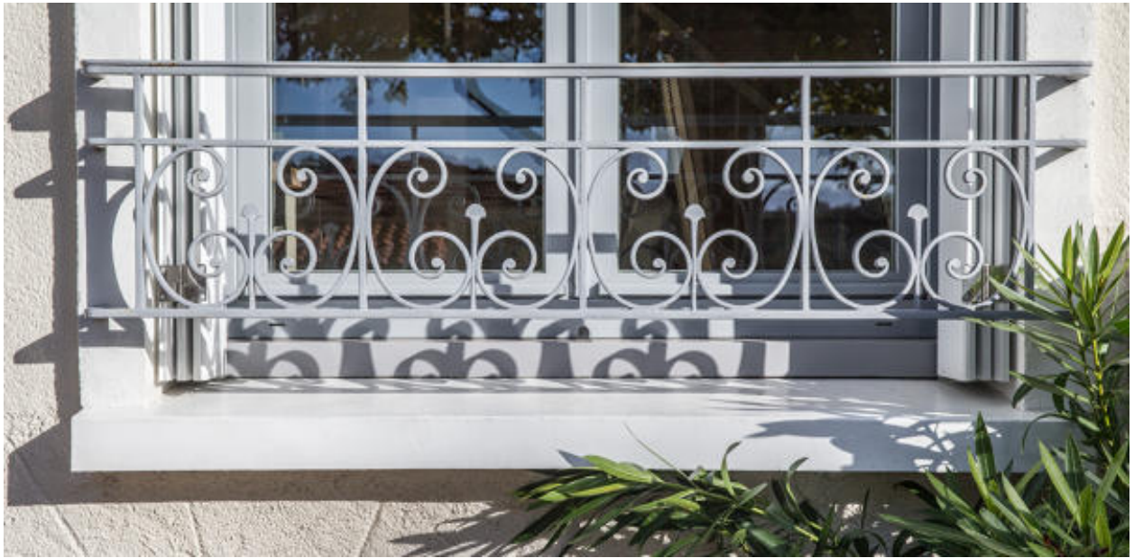
Maison, 18 quai Henri-Brunais. Vue de détail de l'un des garde-corps.
