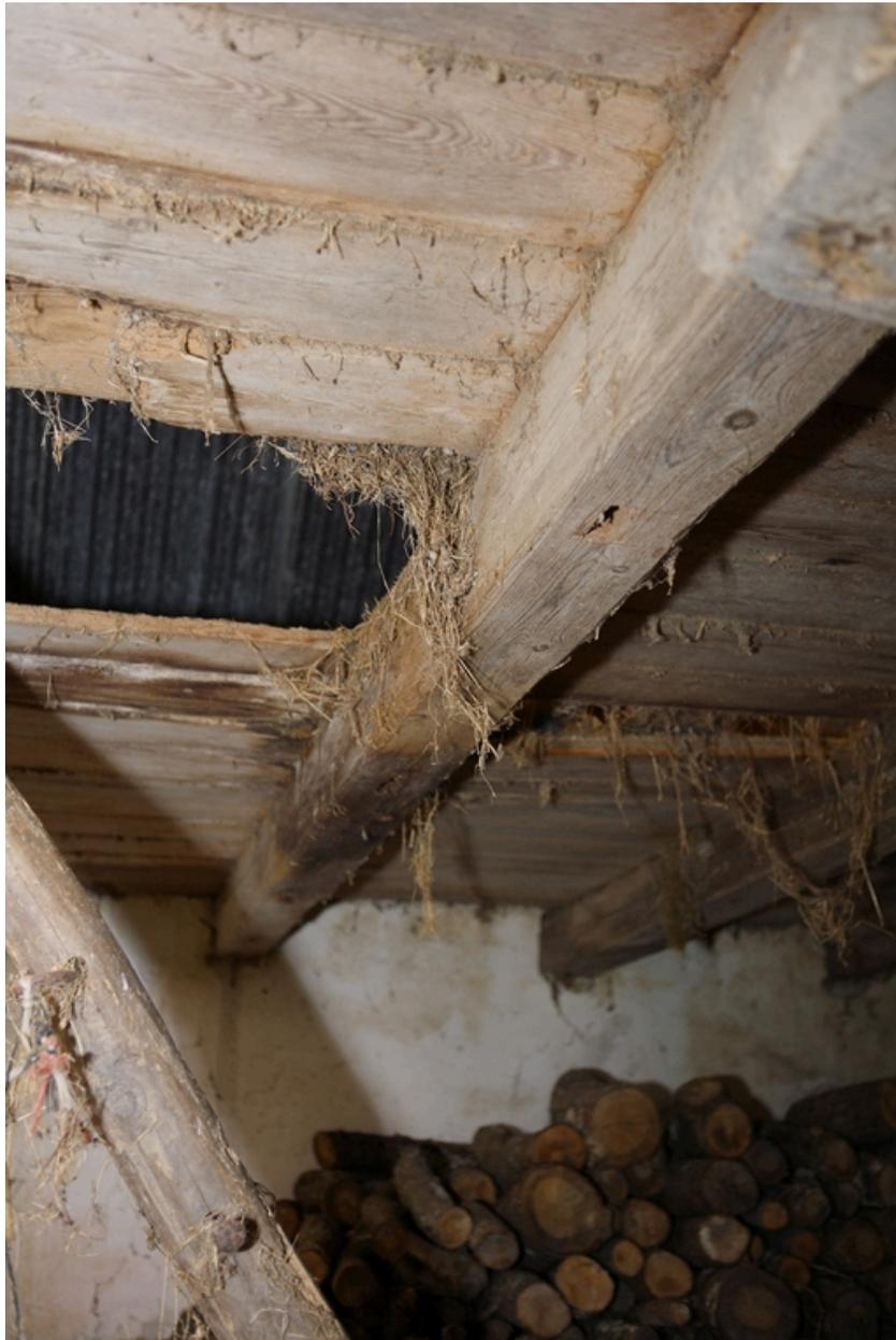
Détail des trous de mortaises dans une solive attestant de la présence d'une cloison en pan-de-bois.
