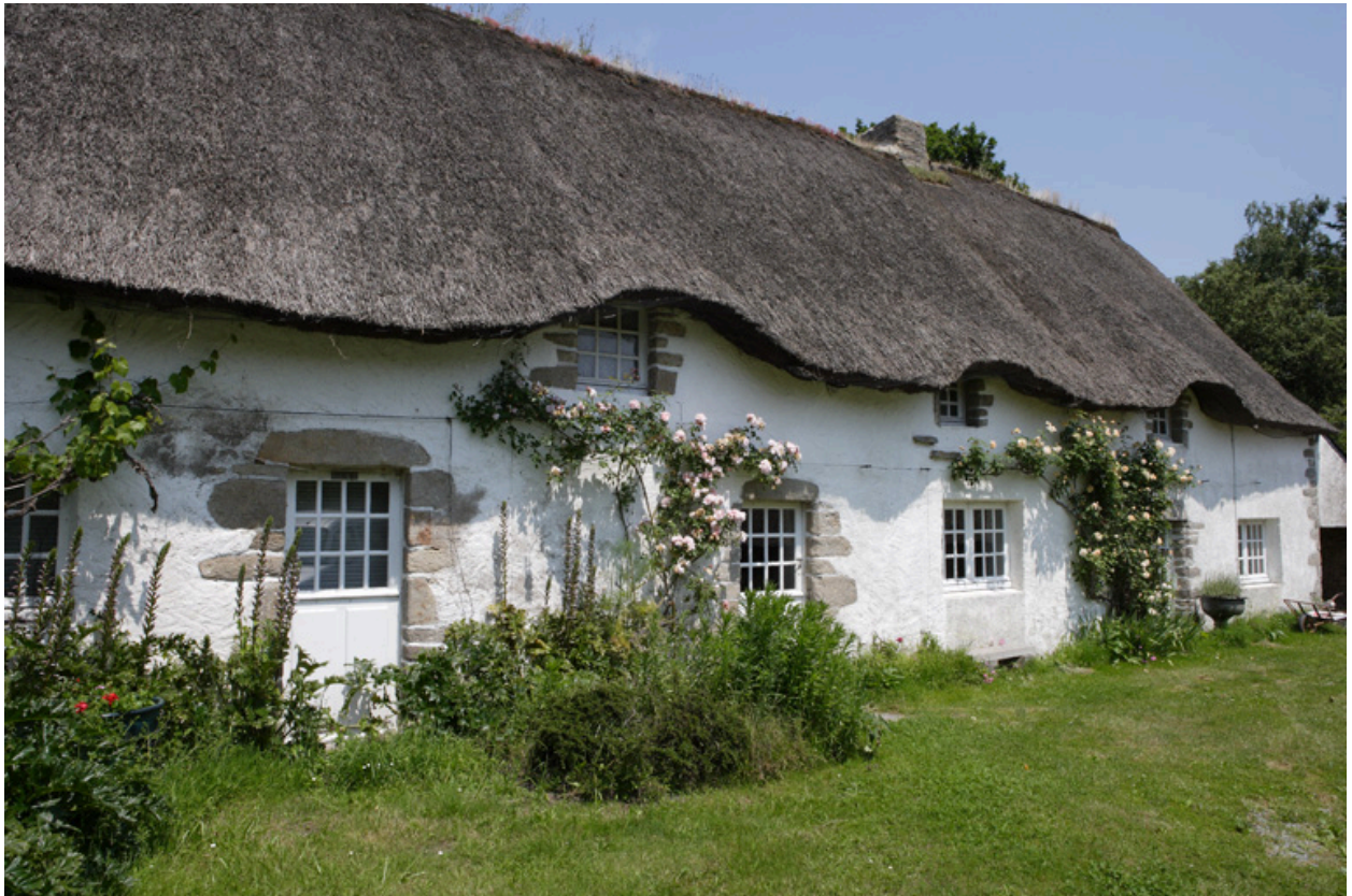
Vue de la façade sud de la rangée depuis le sud-ouest.
